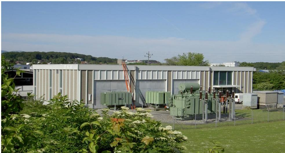
BKW lance la rénovation de la sous-station de Brügg, qui durera jusqu'à 2022. De nombreux éléments de l'installation nécessitent des travaux et doivent être remplacés, et notamment les postes de couplage des niveaux de tension 50 et 16 kilovolts (kV). Ils seront désormais installés comme des installations isolées au gaz afin de gagner de la place. La technique secondaire (conduite et protection) sera rénovée sur l'installation de 132 kV et les transformations.
